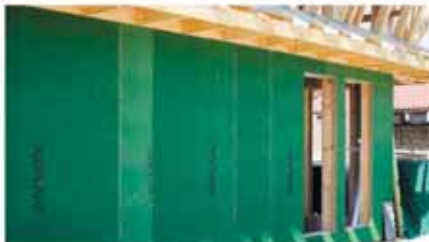
ИЗОПЛАТ - надёжная, герметичная обшивка каркаса и стропил
