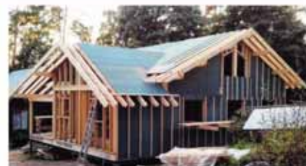
ИЗОПЛАТ - надёжная, герметичная обшивка каркаса и стропил
