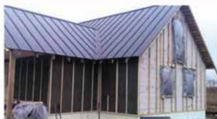
Утепление дома из газобетона
