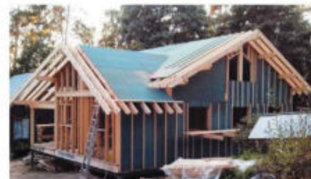
ИЗОПЛАТ - надёжная, герметичная обшивка каркаса и стропил
