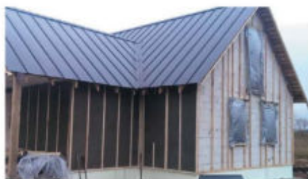
Утепление дома из газобетона
