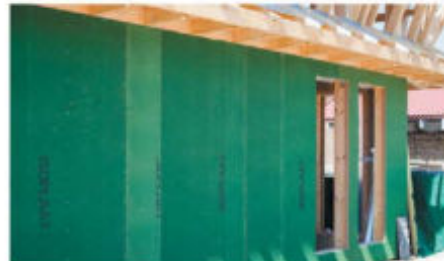
ИЗОПЛАТ - надёжная, герметичная обшивка каркаса и стропил
